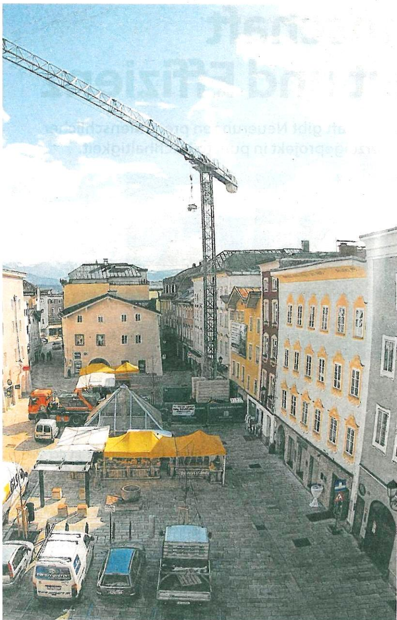
eine Baustelle: Das gelbe Haus rechts wird saniert.
